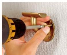
手すり棒の調整が終われば、ブラケットをねじで本止めします。本止めが終われば水糸を取除いてください。
